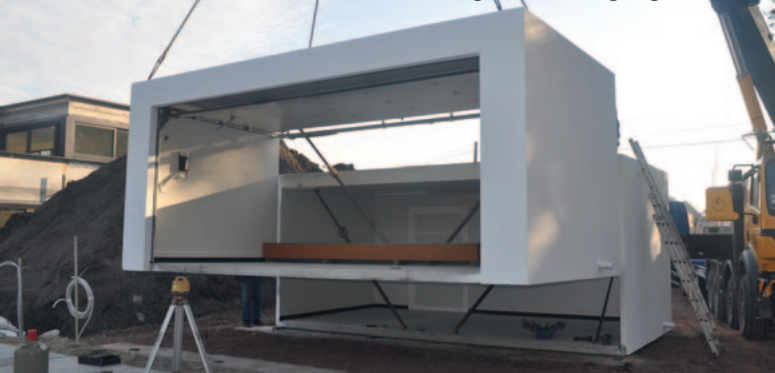
Levering van dubbele garage met kraan
